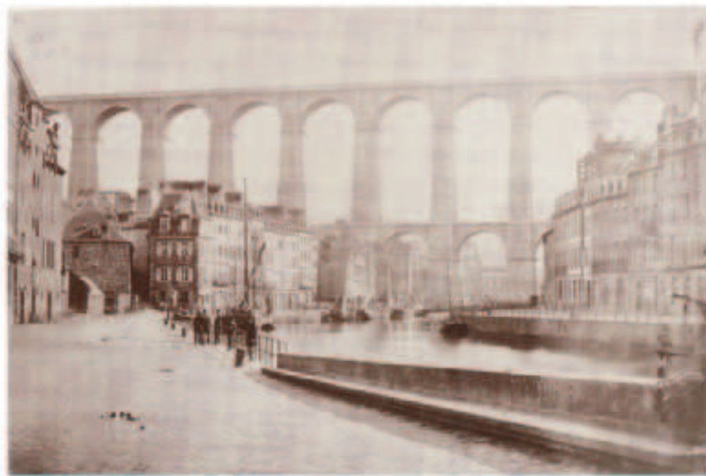
Viaduc de Morlaix - 1876 - Coll. ENPC
