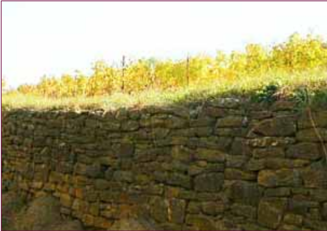
Mur en pierre sèche d'une terrasse viticole
